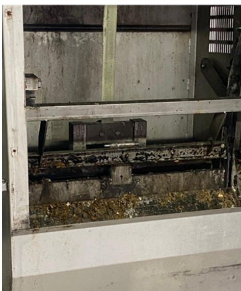
Opération de dégrillage
