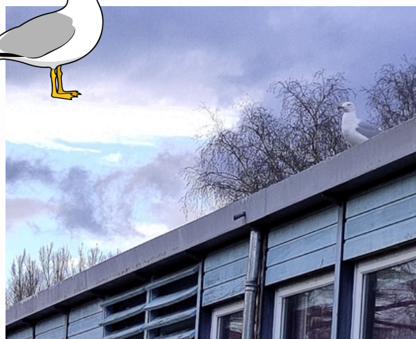
UN GOÉLAND SUR UN TOIT DU BATIMENT C, ANAÏS CHEKKAR
